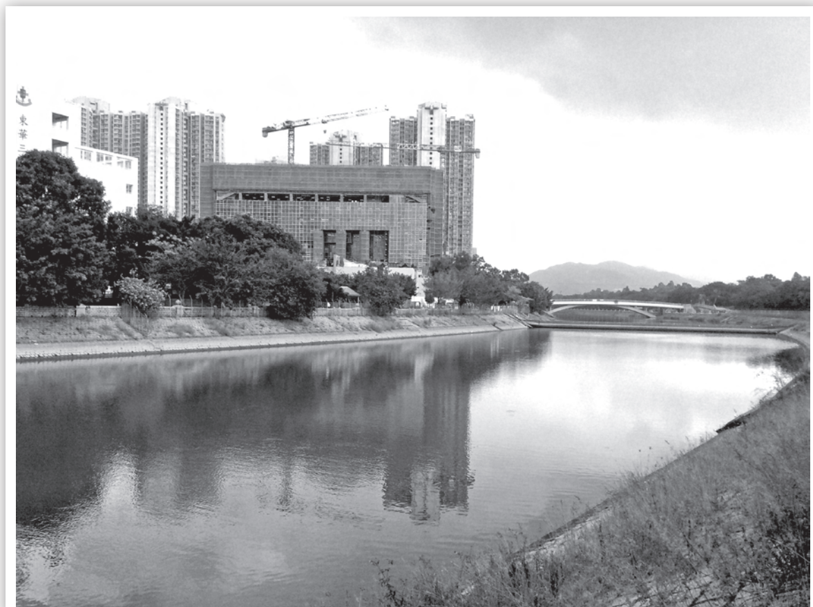
正在興建中之天水圍醫院
