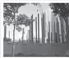
天水圍醫院施工進展情況
